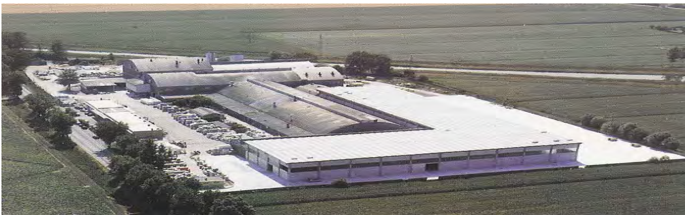
LINCO BAXO industrie refrattari - Bondeno Plant ЛИНКО БАКСО промышленные огнеупоры - завод в Бондено
